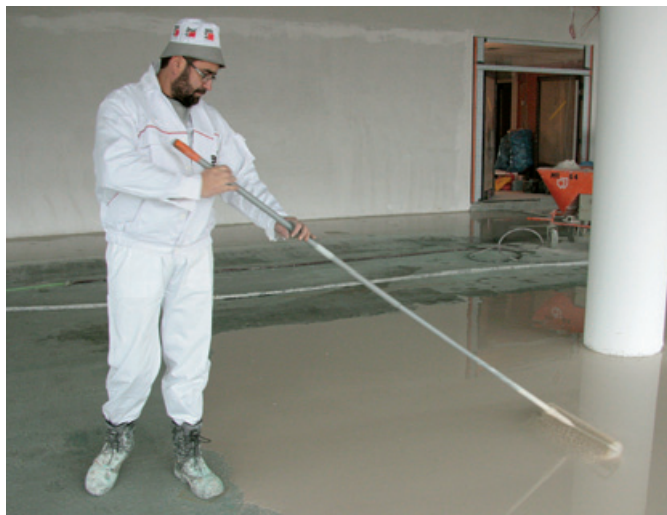
Penetrácia podkladu Baumit Grund
