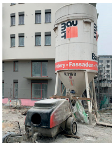
Pneumatický dopravník Estrichboy na spracovanie cementového poteru.
