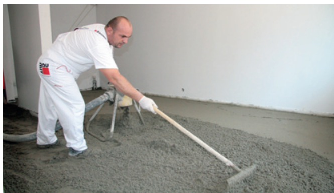
Rozhrnutie poteru Baumit Poter MG
