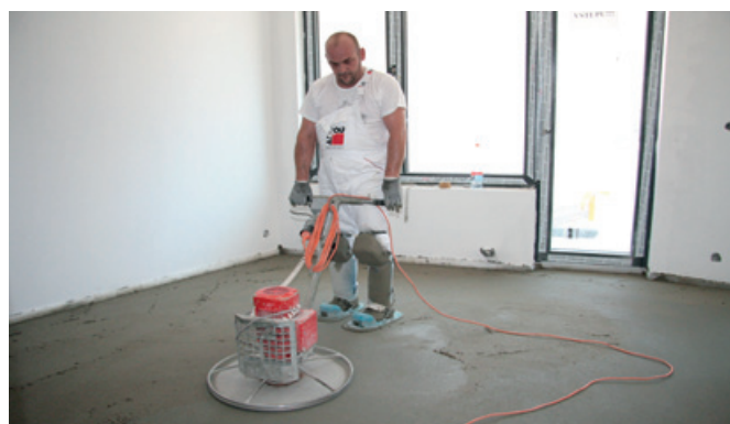
Strojové hladenie poteru Baumit Poter MG
