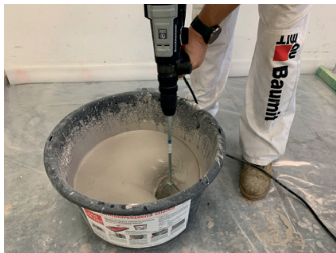
Ručné miešanie elektrickým miešadlom
