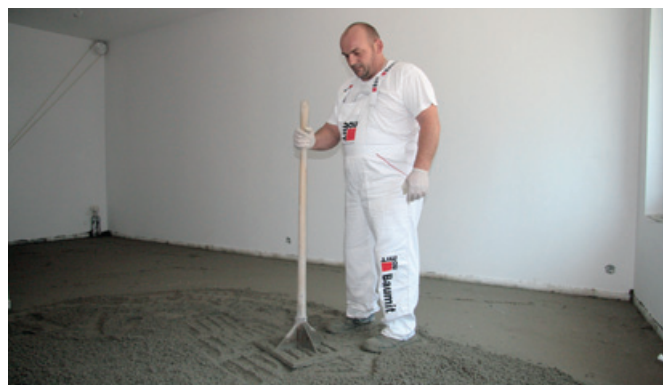
Ručné zhutnenie poteru Baumit Poter MG
