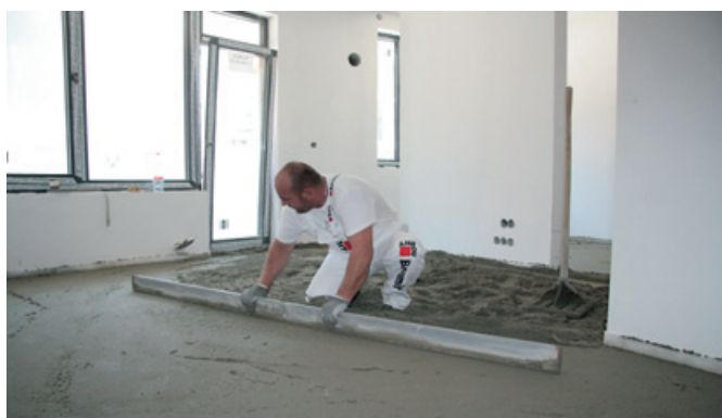
Zarovnanie poteru hliníkovou latou Baumit Poter MG
