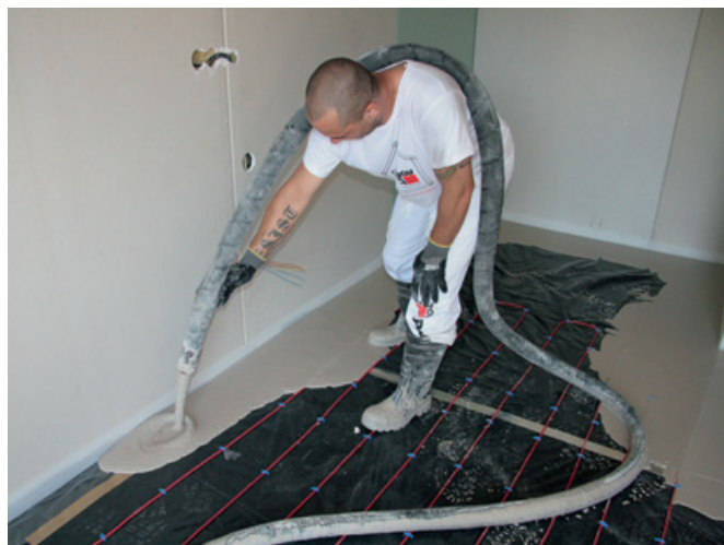
Zalievanie rozvodov podlahového vykurovania
