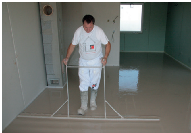
Spracovanie vrstvy čerstvého poteru nivelačnými tyčami
