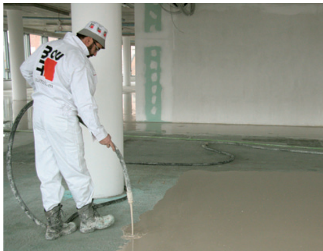
Strojná aplikácia samonivelizačnej stierky
