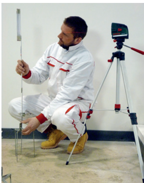
Zameranie požadovaných výšok poterovej vrstvy
