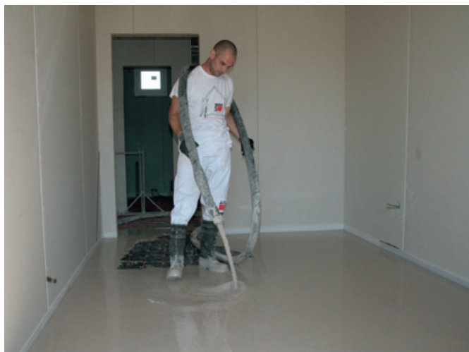
Liatie poterovej zmesi –strojové spracovanie
