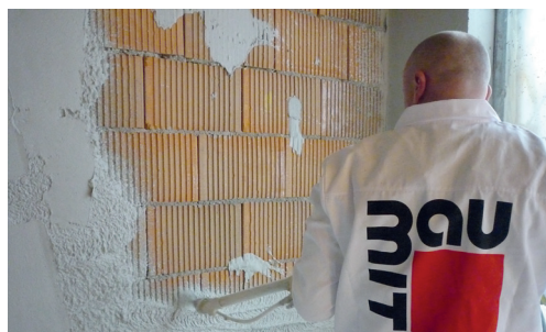
Strojové nanášanie omietky na tehlový podklad
