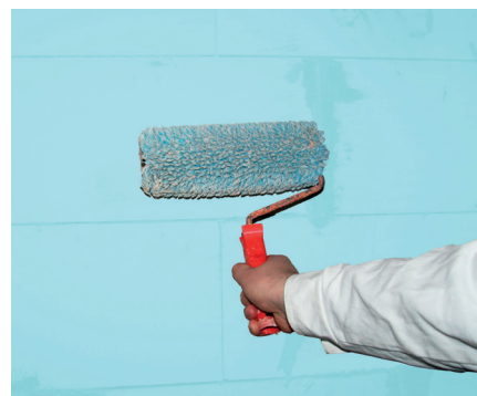
Nanášanie náteru Baumit Grund valčekom
