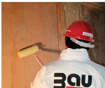
Nanášanie kontaktného mostíka Baumit BetonKontakt valčekom
