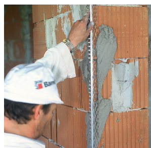
Osadenie rohového profilu
