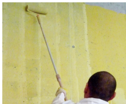
Nanášanie kontaktného mostíka Baumit SuperPrimer valčekom
