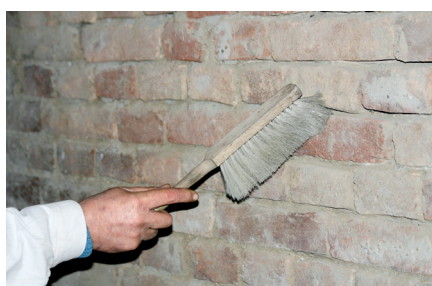
Zbavenie podkladu prachu metličkou
