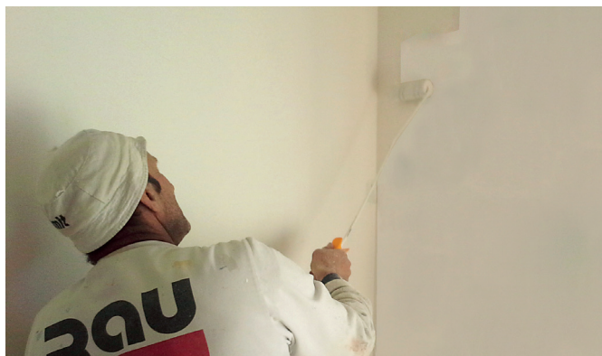
Nanášanie Baumit FillPrimeru pomocou valčeka
