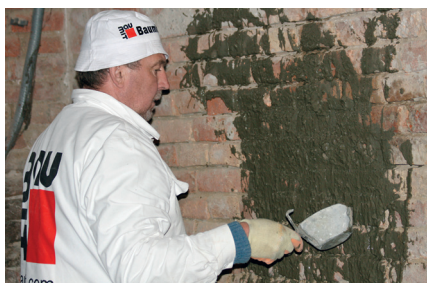
Nanášanie cementového „špricu“ Baumit Prednástreč 2 mm
