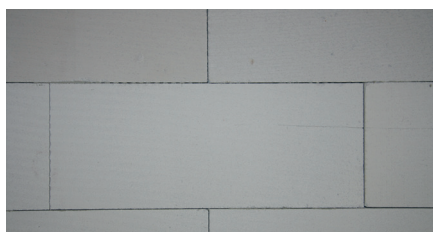
Presne murované pórobetónové murivo
