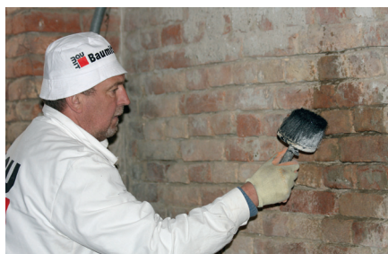
Vlhčenie podkladu pred omietaním
