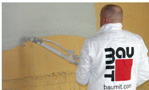
Strojové nanášanie omietky na betónový podklad opatrený kontaktným mostíkom Baumit SuperPrimer
