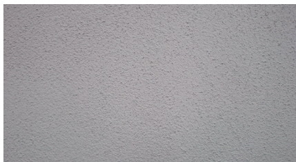
Hrubá hladená štruktúra so zrnitosťou 1,0 mm
