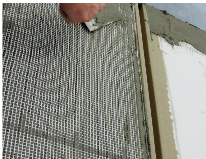
Vytvorenie výstužnej vrstvy
