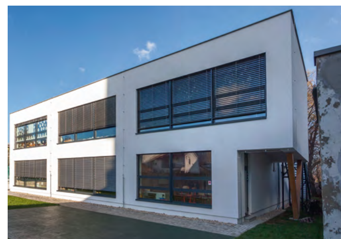
Materská škola, Bajkalská, Bratislava
