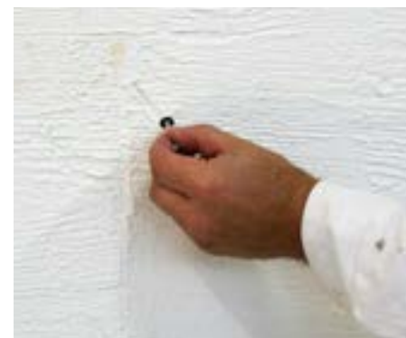
Vytvoriť odtlačok – imitáciu klinca na čerstvo nanesenej omietke Baumit CreativTop Pearl.
