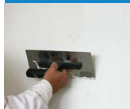
Naniesť podkladovú vrstvu CreativTop Vario.
