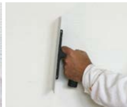
Po vytvrdnutí vyhladiť nerovnosti antikorovým hladidlom.
