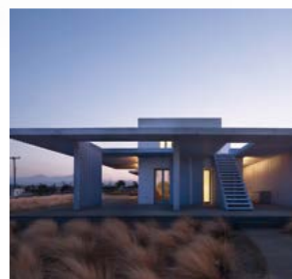
House A-2 | Grécko Architekt: Stephan Buerger, Demetra Katso- ta, Maria Chassioti, Georgios Kourakos, Klelia Siska
